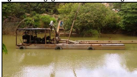
Figura 2: Dragagem de areia nas margens.
