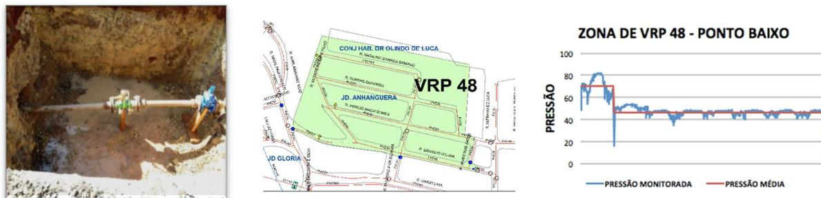
Figura 7: Instalação de VRP 48 (a), região de abrangência (b) e redução de pressão no ponto baixo (c).
