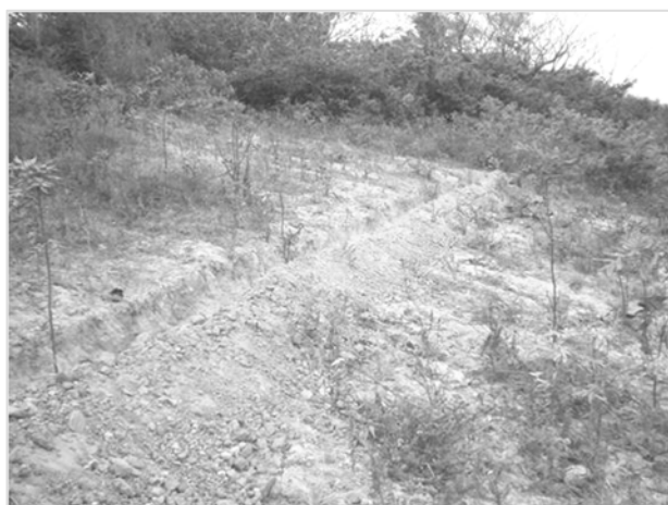
Figura 3: Valeta construída com 1,7% de declividade para desviar a água do talude para a calha de drenagem da estrada.
