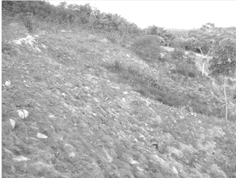
Figura 9: Talude remodelado e aplicado a fibra do coco após três meses. São Cristóvão/SE, 2008.
