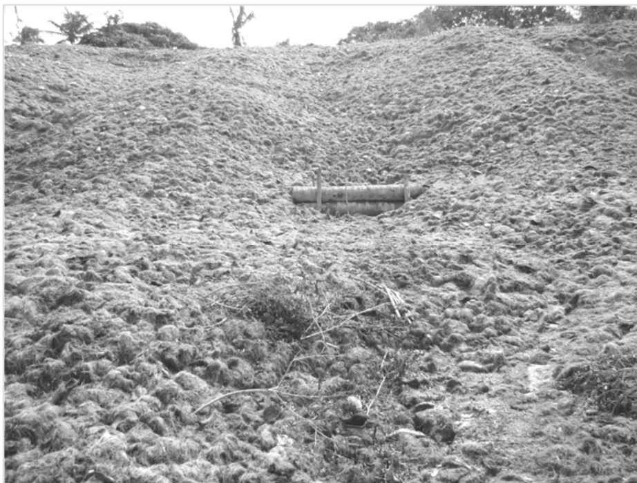
Figura 7: Instalação de paliçada de Pindoba ( Syagrus coronata ) no sulco principal.
