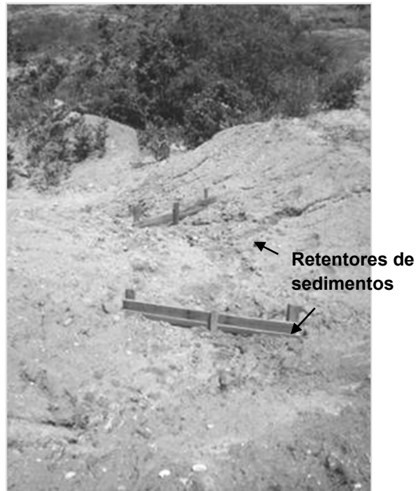
Figura 6: Dissipadores de energia (retentores de sedimentos) colocados nas vertentes dos taludes remodelados para atenuar o escoamento superficial.
