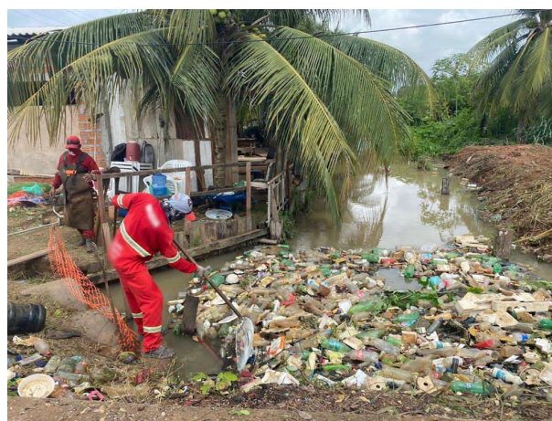
Figura 4: Desobstrução dos canais de macrodrenagem em Macapá. Fonte: PMM (2020).
