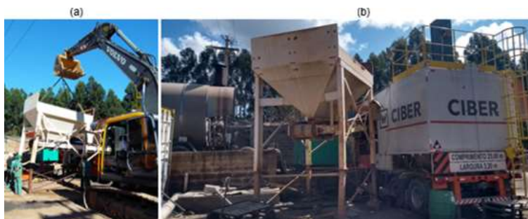
Figura 7: Instalação (a) e posicionamento do silo alimentador de RAP em relação a usina (b).
