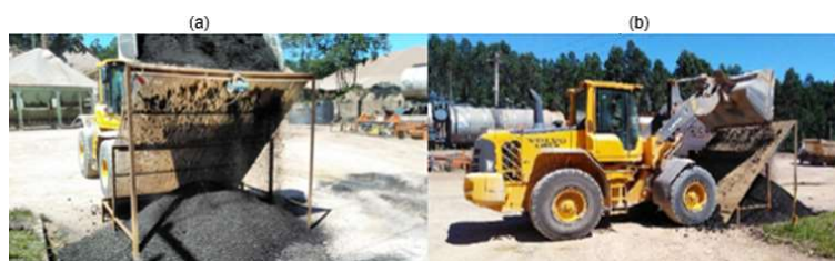
Figura 5: Processo de separação das frações do RAP: vista inferior (a) do peneiramento e posicionamento da carregadeira (b).
