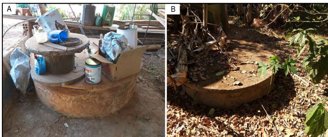
Figura 3: Condições de limpeza inadequada no entorno dos poços do bairro Módulo VI, em Juína – MT Legenda: (A) Ponto 1 (B) Ponto 3.
