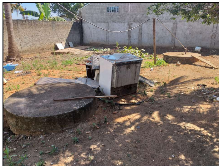
Figura 4: Localização do poço (P2) em relação a fossa, no bairro Módulo VI, em Juína – MT.
