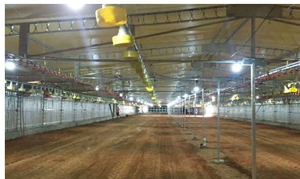
Figura 4: Pavilhão aviário em alumínio – vista interna.
