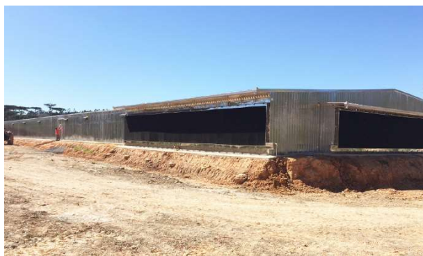
Figura 3: Pavilhão aviário em alumínio – vista externa.
