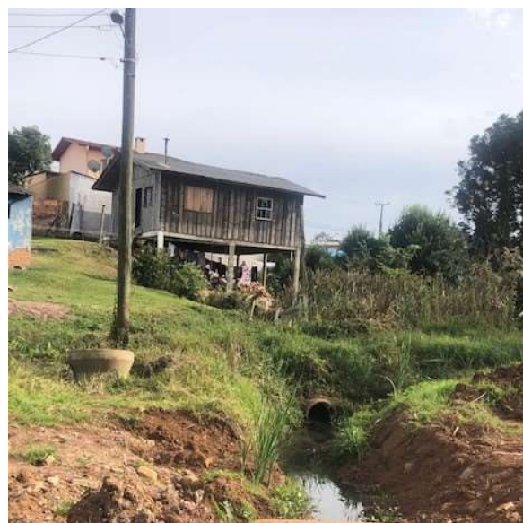
Figura 86: Despejo irregular de esgoto doméstico.
