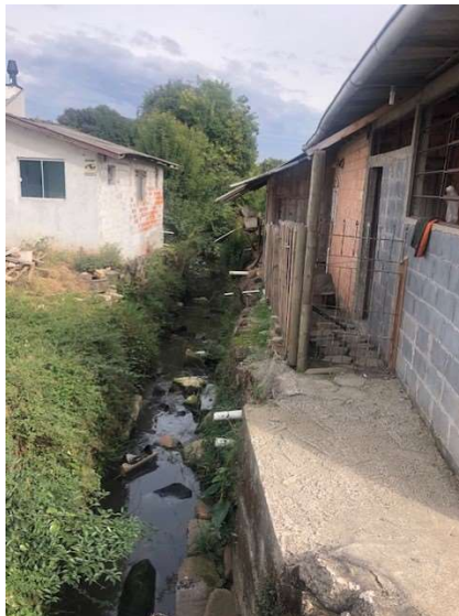
Figura 5: Ocupação consolidada em córrego afluente do rio Ponte Grande.
