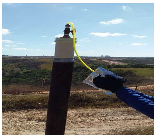
Figura 2: Coleta de gás nos drenos verticais.
