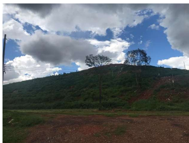
Figura 4: Cobertura vegetal nos taludes do aterro sanitário de Goiânia/GO.
