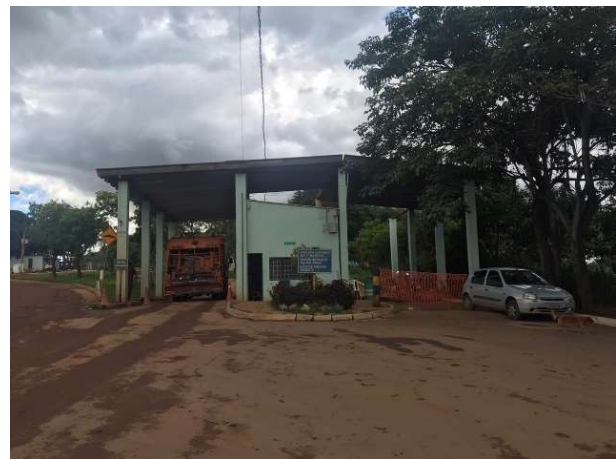
Figura 2: Balança do aterro sanitário de Goiânia/GO.
