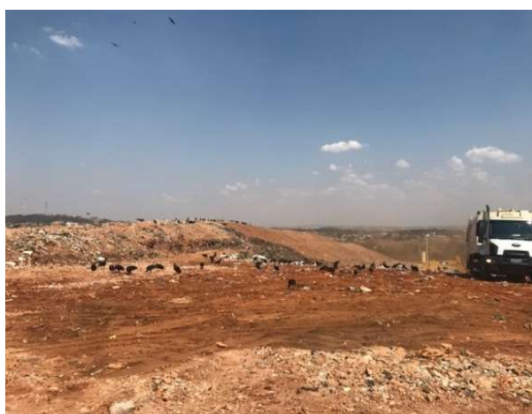
Figura 5: Superfície superior com nivelamento e homogeneidade em condições insatisfatórias.
