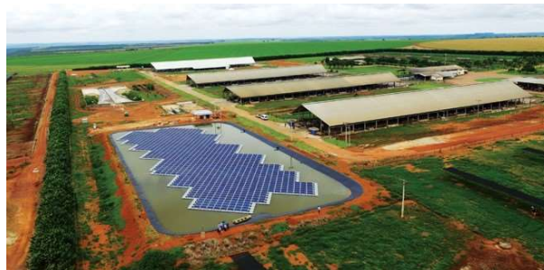
Figura 3: Painéis solares utilizados como redutores de evaporação e geradores de eletricidade. Fonte: MTEC (2017).
