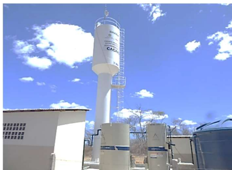
Figura 4: Estação de Tratamento de Água da VPR Cacaré.
