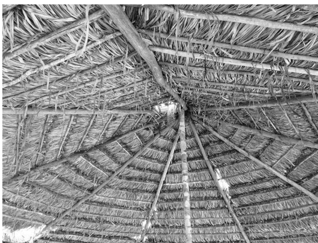
Figura 5: Cobertura da estrutura do telhado do Centro de Conferência da Aldeia Indígena Itapoã Tupinambá de Olivença.
