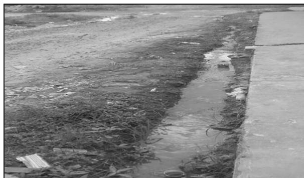
Figura 12: Presença de esgoto escoando a céu aberto na Rua Nanbiquara.
