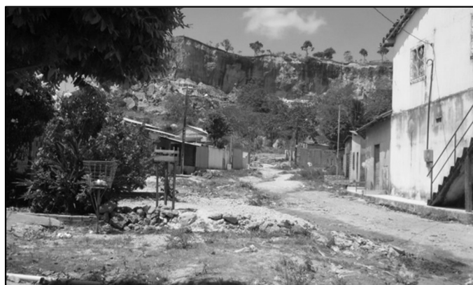
Figura 2: Ocupação em área de risco na Rua Naiara.
