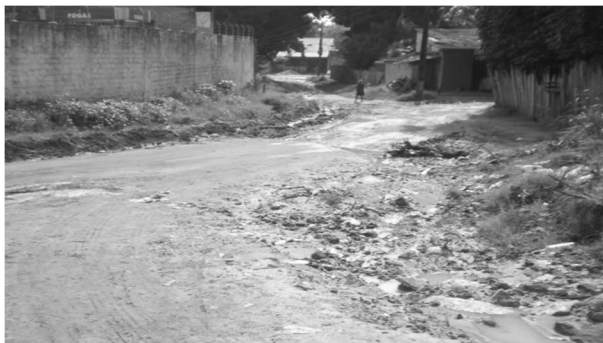
Figura 11: Acúmulo de água na Rua Itapuã.
