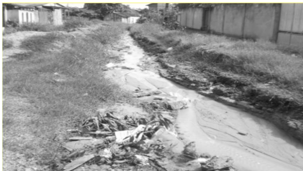
Figura 10: Pésimas condições da Rua Jupiara.
