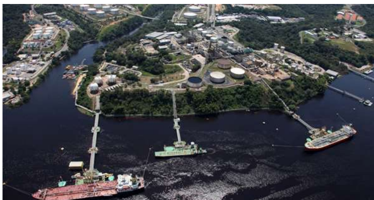
Figura 4: Refinaria ISAAC SABBÁ – REMAN. Fonte: PETROBRAS (2014).
