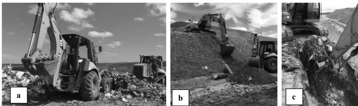
**Figura 6:** Coleta dos resíduos: (a) célula em operação – coleta de resíduos frescos; (b) retirada da camada de cobertura - célula com 2 anos; (c) coleta dos resíduos - célula com 2 anos.
