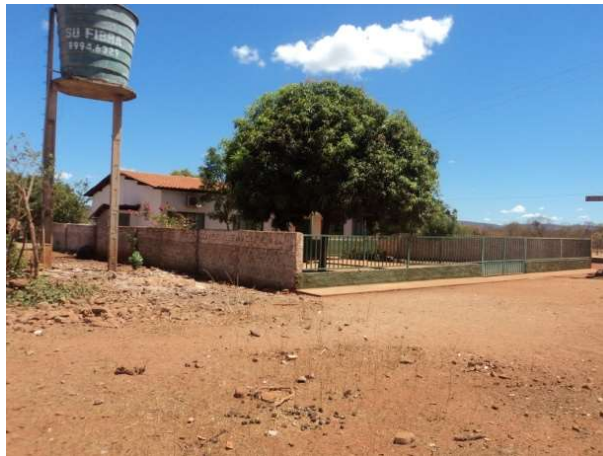
Figura 7: Poço e reservatório da localidade Jenipapeiro e ao lado um posto de saúde. Fonte: Santiago (2016).
