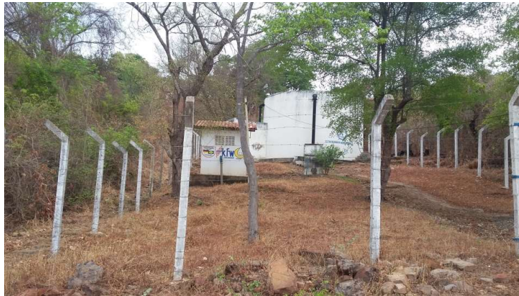
Figura 9: reservatório recém-construído para suprir a demanda da população da cidade de Santa Cruz dos Milagres. Fonte: Santiago (2016).
