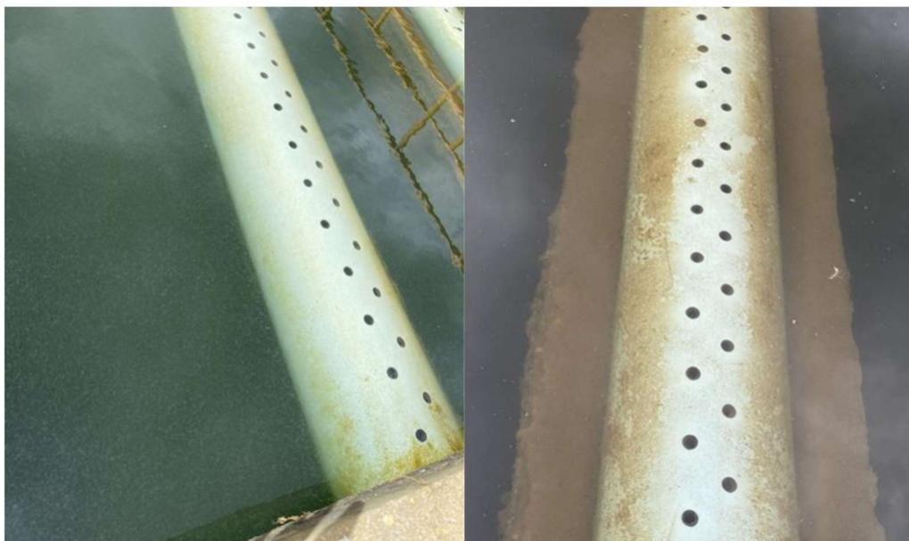
**Figura 4:** Incrustação de flocos nas calhas de coleta de água decantada.
