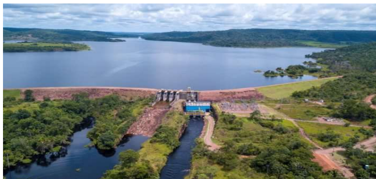
Figura 5: Pequena Central Hidrelétrica Guarantã Energética S.A. Fonte: PCH (2021).
