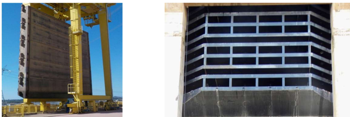
Figura 2: Imagem fotográfica do plano de face e detalhamento das estruturas de fundo/gavetas da comporta vagão utilizada no procedimento operacional de fechamento do tubo de sucção durante parada da unidade geradora.
