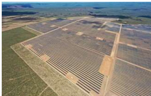
Figura 4: Usina de grande porte de São Gonçalo/PI.
