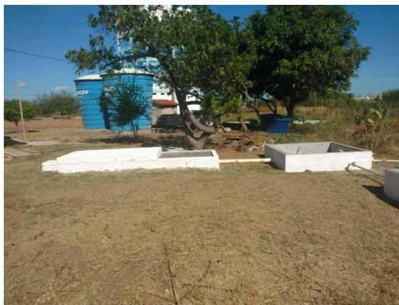
**Figura 3:** Vista lateral do sistema compacto de tratamento e uso agrícola e florestal de águas cinza. **Nota:** 1 - Tanque de equalização; 2 - Tanque séptico; 3 - Filtro anaeróbico; 4 - Reator ultravioleta artificial; 5 - Vala de infiltração e 6 - Área de reuso agrícola e florestal (6).
