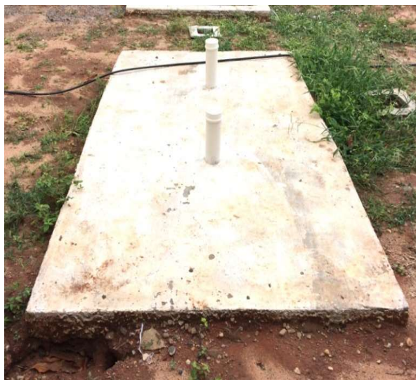
Figura 2: Vista superior do tanque séptico.
