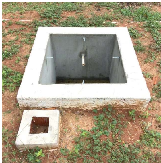
Figura 7: Vista superior do reservatório.
