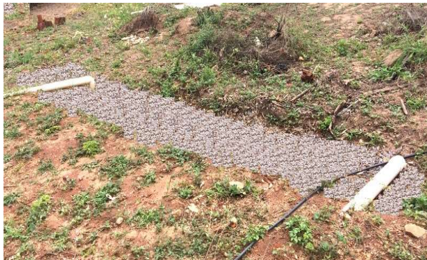
Figura 6: Vista superior da vala de infiltração.
