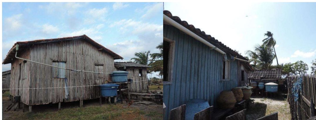
Figura 4: Tipos de sistema de reaproveitamento de água da chuva presentes na comunidade.
