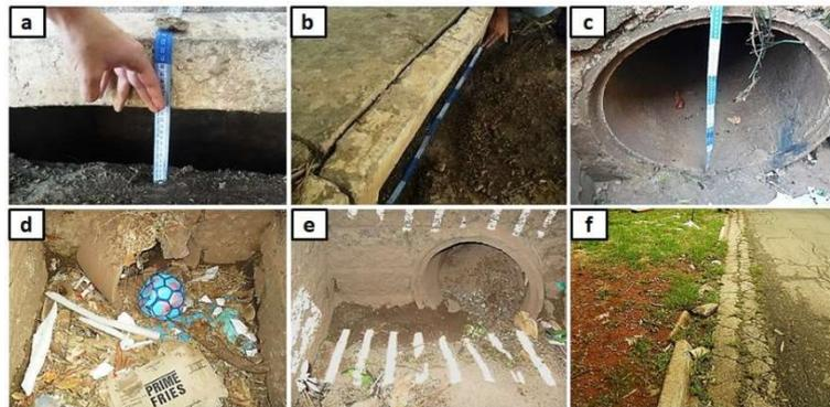
**Figura 2:** Condições da microdrenagem analisada *in loco*. Altura e comprimento das bocas de lobo (a) e (b); Tubulação limpa (c); Tubulação suja (d); Tubulação entupida de sedimentos (e); Guias e sarjetas: ausência ou quebradas (f).
