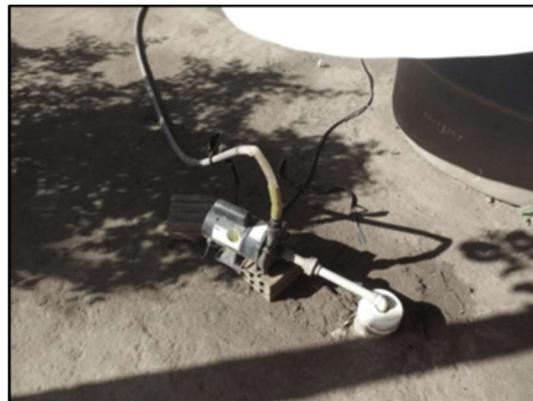
**Figura 3:** Poço semiartesiano, captação por bomba.
