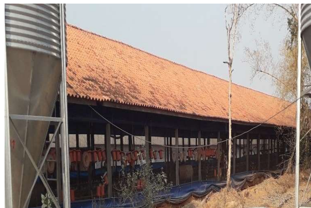
Figura 2: Exterior do aviário com sistema de pressão positiva (intensivo) na Granja Jucelino em Cacoal-RO.
