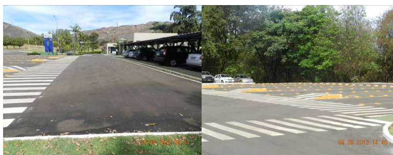
Figura 3: Estacionamento para embarque e desembarque de passageiros concluído.
