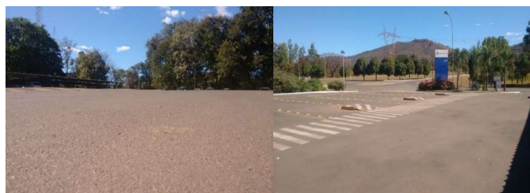
Figura 5: Vista do pavimento após quatro anos de execução.
