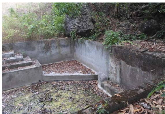
Figura 9: Nascente N2-DD Com proteção e o reservatório para a água da nascente (2017).
