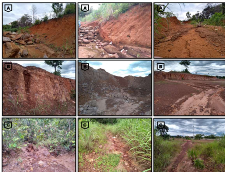
Figura 1: Identificação dos processos erosivos. (A) Ponto de monitoramento 01; (B) Ponto de monitoramento 02; (C) Ponto de monitoramento 03.
