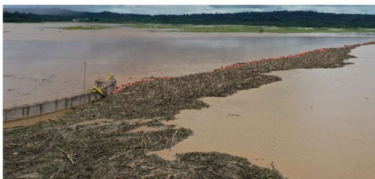
Figura 02: Catenária do antigo Log Boom instalado a montante do barramento da Usina Hidrelétrica de Jirau, Rio Madeira (RO).
