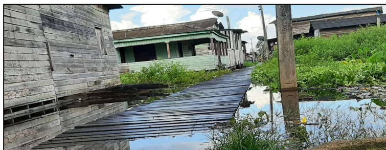
Figura 2: Áreas de palafitas que interligam a Rua da Antiga Usina.
