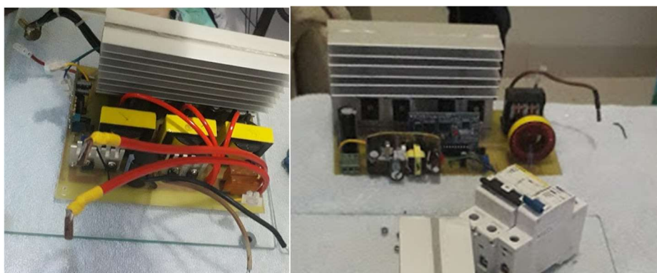
Figura 7: Verificação de circuito de todo o sistema interno do Inversor (desmontagem).
