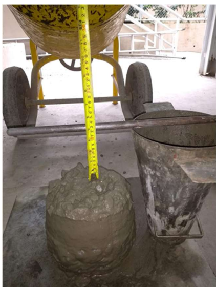
Figura 4: Slump test concreto convencional.
