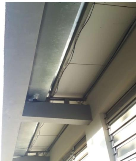
**Figura 8:** Bocal da calha.
