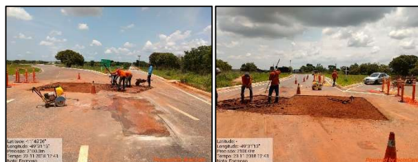
Figura 5: Fresagem com Recomposição em CBUQ-TO-242.
