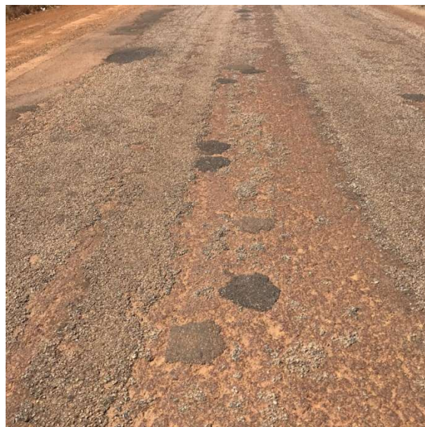
Figura 5: TO-255, Km 5, Trecho de Porto Nacional a Monte do Carmo (TO).
