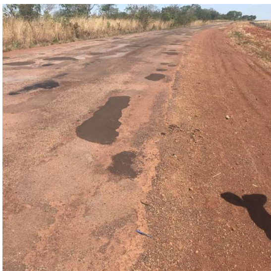
Figura 6 – TO-255, Km 27, Trecho de Porto Nacional a Monte do Carmo – TO.
