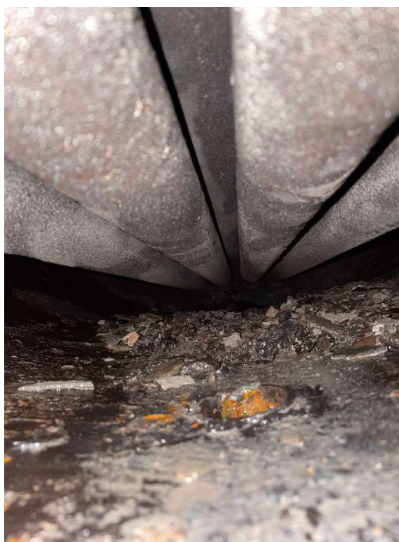
Figura 3: Exemplo de depósito de lama em caldeira.
