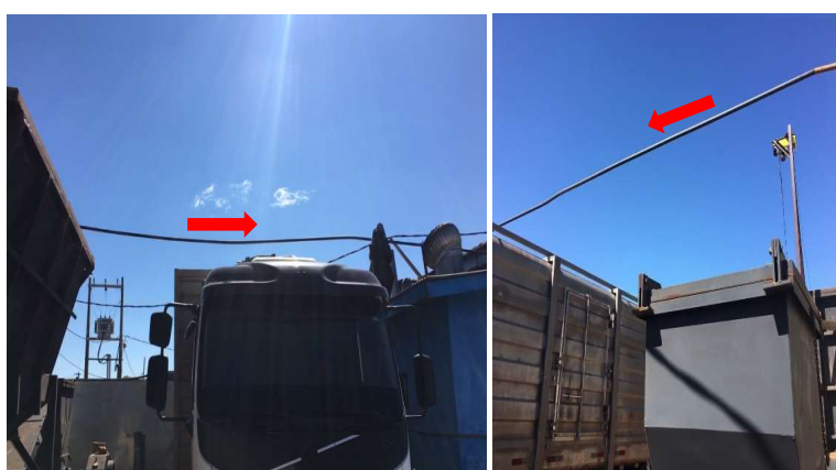
Figura 5: Linha tubulação de vapor para processo.
