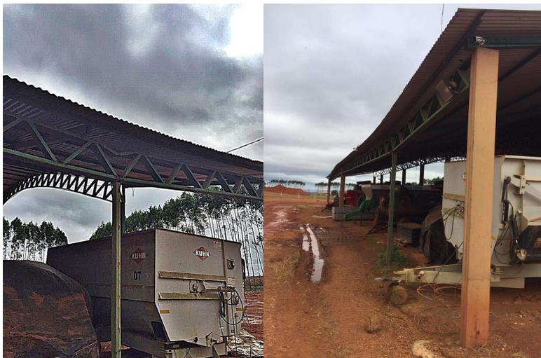
**Figura 5a e 5b:** Deformação no banzo superior.
