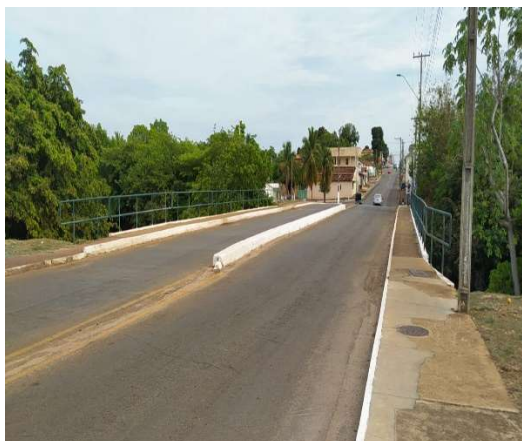
Figura 1: Vista frontal da Ponte.
