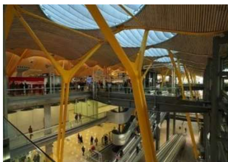
Figura 6: Forro em bambu e clareiras de vidro no aeroporto Barajas, Madri, Espanha. Fonte: Arquitetura Unimar (2012).
