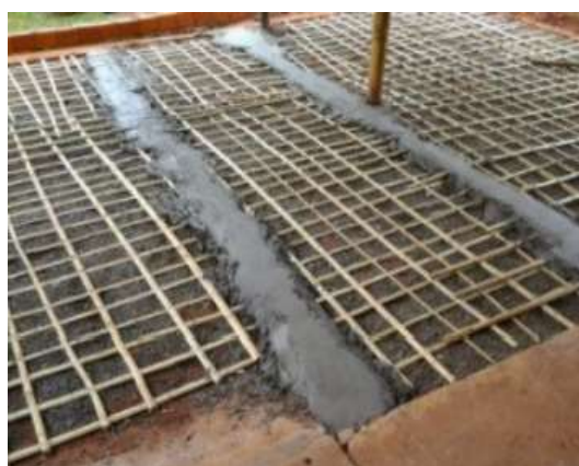
Figura 7: Utilização de bambu em substituição ao aço em concreto armado. Fonte: Rodrigues (2015).
