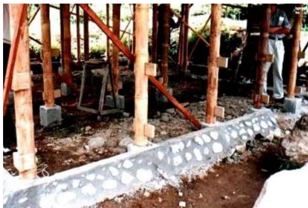
Figura 1: Pilares de bambu apoiados em base de concreto. Fonte: Teixeira (2006).
