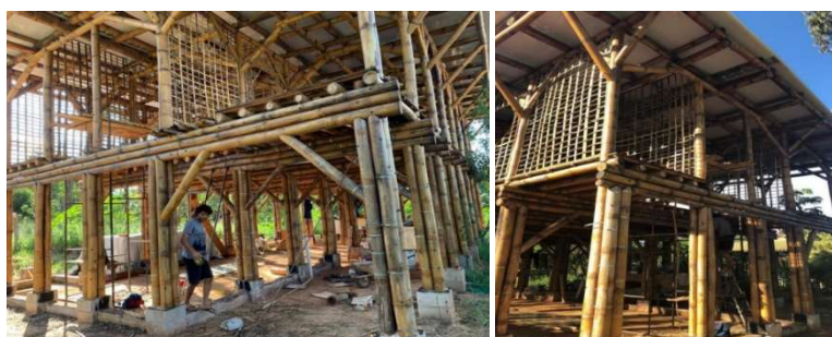
Figura 9: Casa de Hidrolândia-GO construída com bambu. Fonte: Ludwing et al. (2019).
