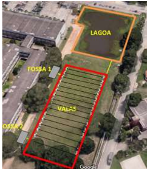
Figura 2: Sistema de Tratamento de água residuária do IFPE- Campus Recife.
