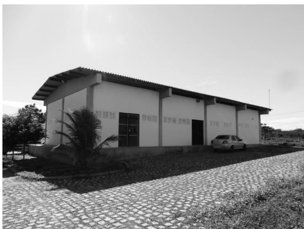
Figura 8: Vista externa do abrigo de resíduos da UFERSA.
