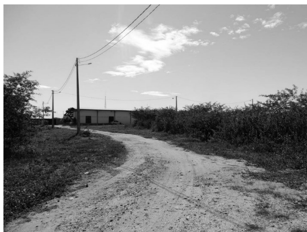
Figura 9: Localização do abrigo de resíduos da UFERSA, afastada das demais estruturas físicas.
