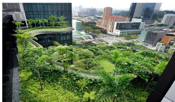
**Figura 6:** Telhado Intensivo.
