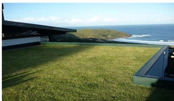
**Figura 5:** Telhado Extensivo.
