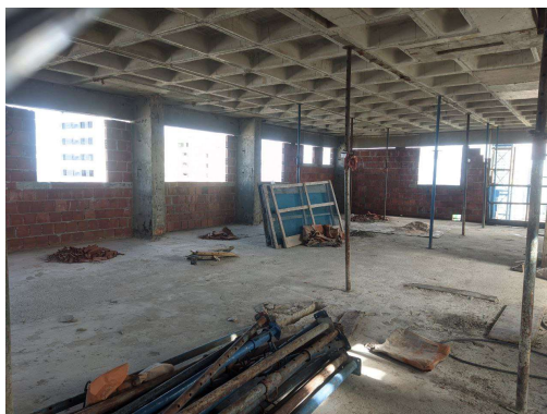
Figura 4: Foto in loco interna da obra 01, mostra os resíduos separados.
