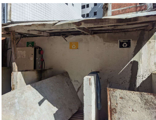
Figura 7: Uso de baias sinalizadas para acondicionamento dos resíduos (Obra 2).
