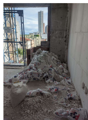
Figura 6: Imagem interna da obra 01.
