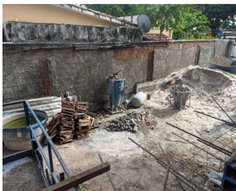
Figura 2: Disposição dos resíduos no canteiro de obra (Obra 1).
