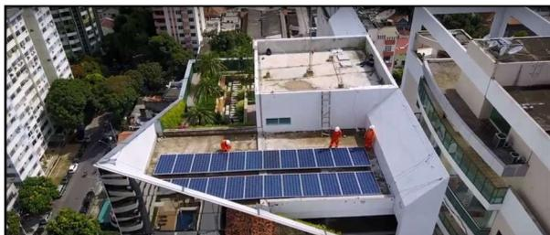
**Figura 1:** Vista aérea da instalação de painéis fotovoltaicos: Torre Infinito, Belém.
