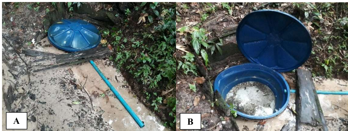
Figura 8: a) adaptação de uma caixa d'água como ferramenta de proteção de nascentes; b) nascente parcialmente protegida. Sítio Jonas. Nova Timboteua – PA.
